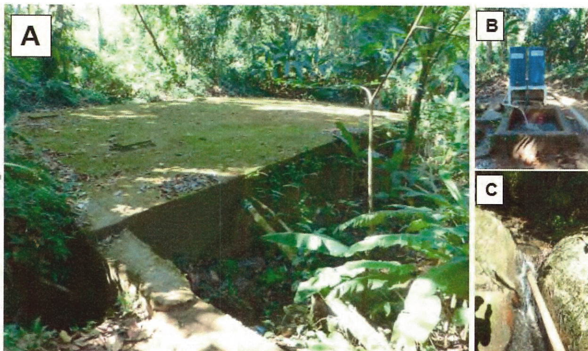
Figura 3.1-53: Em A), cisterna operada pela SAAE, localizada na Universidade Federal Fluminense (UFF) e que abastece o bairro do Retiro (localização: 0568250/7456485, elevação 38m); em B) Clorador de água da cisterna; em C) Captação no Córrego do Retiro. Fotografia de João P.C. Araújo (julho de 2019)
